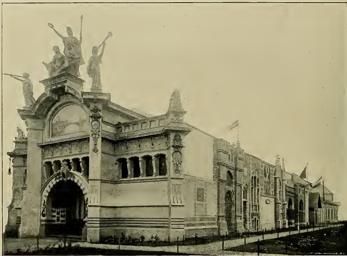
LE PAVILLON DU GÉNIE CIVIL. — VUE EXTÉRIEURE.
